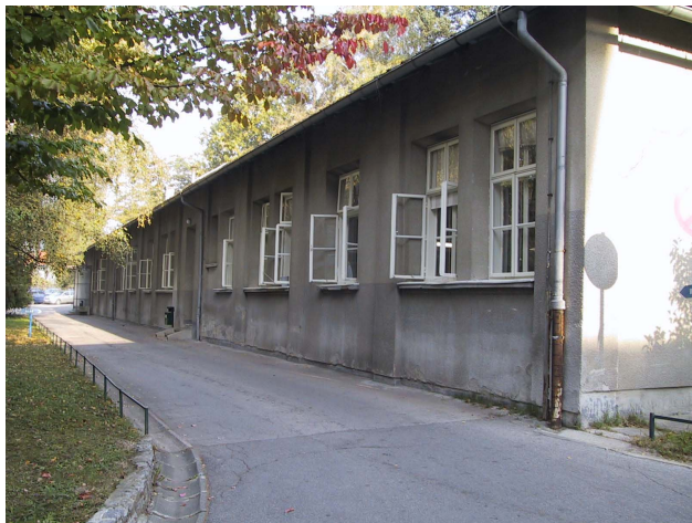
Slika 3. Vanjski izgled najstarije zgrade (nepromijenjen do danas) izgrađene 1893. god. Kužna bolnica - gradska karantena za izolaciju i liječenje bolesnika od zaraznih bolesti, s mogućnošću desinfekcije prostora i stvari.
